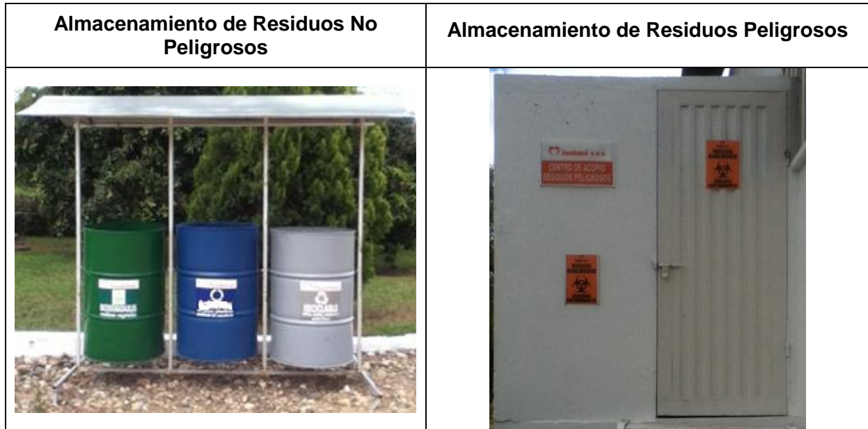
Figura 2. Unidades de almacenamiento para Residuos No Peligrosos y Residuos Peligrosos
